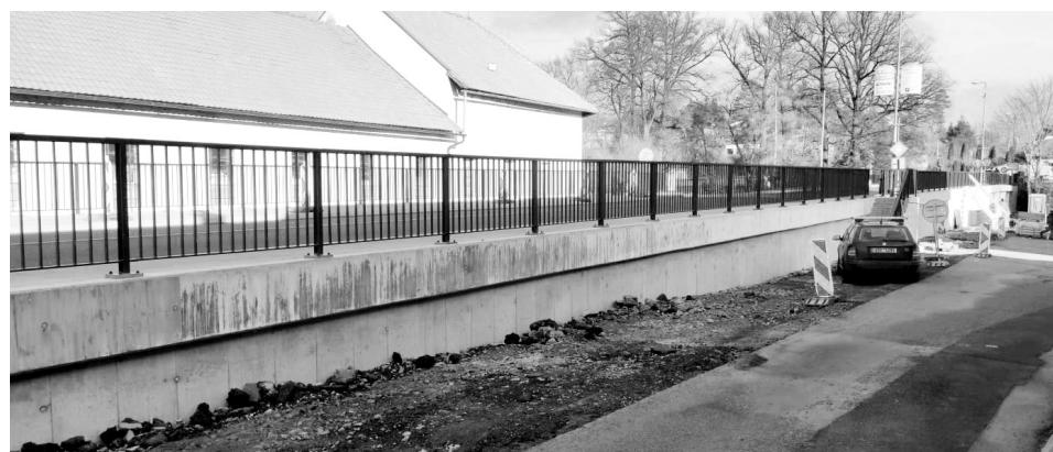
Aktuální podoba staveniště mostu přes Mastník v pondělí 3. února odpoledne. Foto: Luboš Procházka
