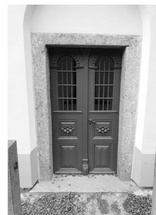
Opraveny jsou i dveře.
