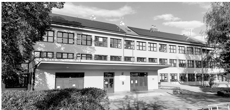
Na střeše školy jsou již instalované panely fotovoltaické elektrárny.
