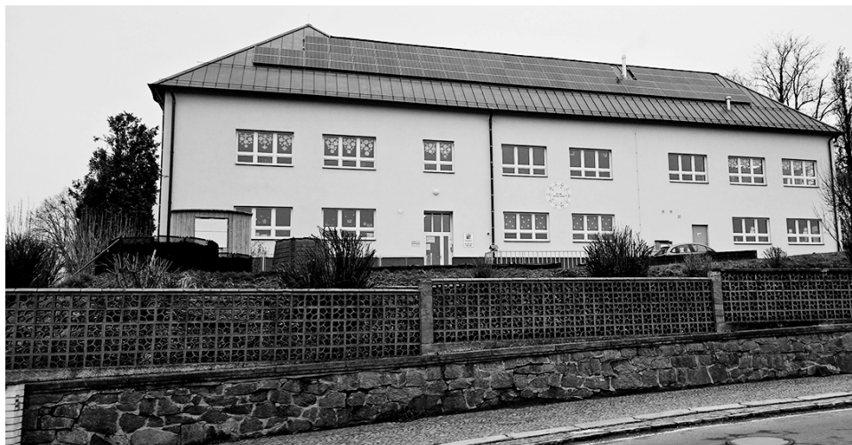
Fotovoltaické panely na kosohorské škole
