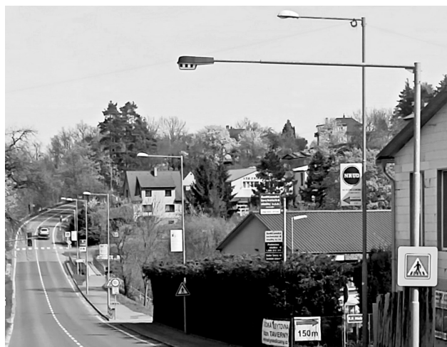
Dosavadní veřejné osvětlení v Sedlčanech
