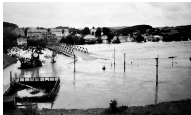
Povodeň v roce 2002 vyzkoušela nejen pevnost a konstrukci mostu, ale také psychickou odolnost místních občanů. Foto: David Štverák
