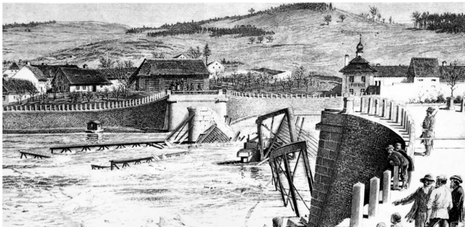
Torzo a trosky zříceného mostu při povodni roku 1888. Foto: Obec Kamýk nad Vltavou
