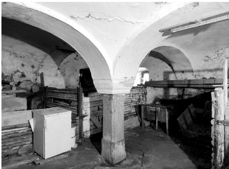
Ve chlévě je architektonická zajímavost, zachovalý klenutý strop, který celý podpírá jeden masivní žulový sloup.
