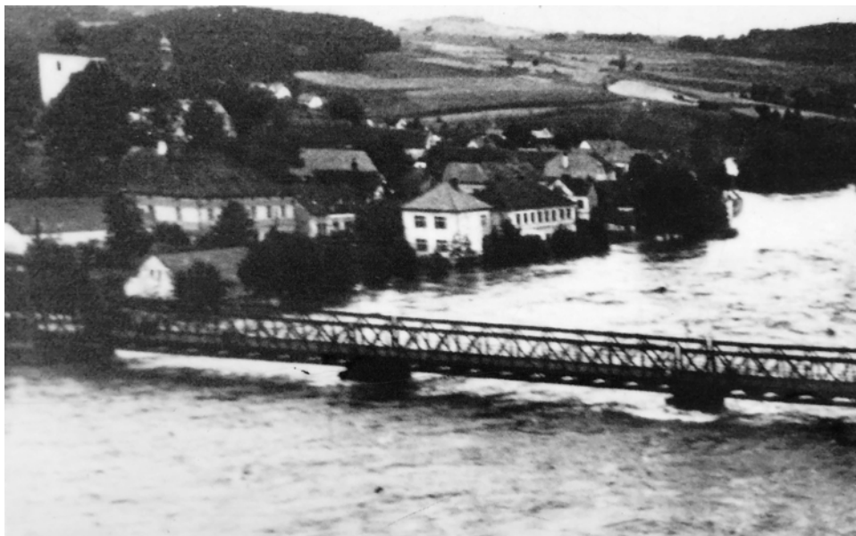
Konstrukce mostu při povodni roku 1954, most byl tehdy níže položený, zvedl se přístavbou pilířů při rekonstrukci v roce 1999. Foto: Obec Kamýk nad Vltavou
