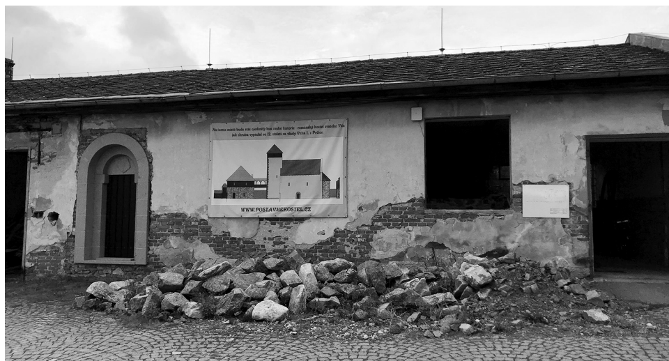
Kostelík vzniká pomalu na půdorysu původní stavby. Na její obvodové zdi je již nyní k vidění vizualizace budoucího stavu.
