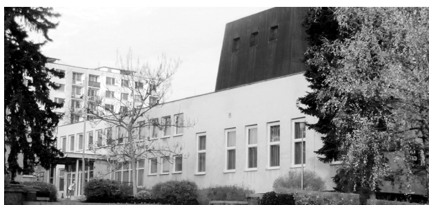
K vystavění fotovoltaické elektrárny přímo nahrává budova kulturního domu. „Objekt pro to má dobré podmínky – velkou rovnou střechu s možností optimálního postavení panelů,“ uvedl ředitel Martin Severa.
