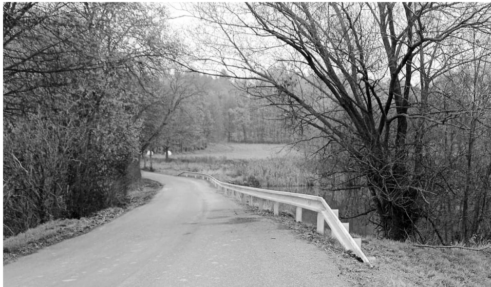
U rybníka Shorný nedaleko Zahrádky bylo konečně instalováno bezpečnostní zařízení v podobě svodidel na pozemní komunikaci.
