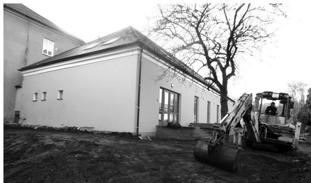
Nové komunitní centrum ve farní zahradě stojí na místě původní hospodářské budovy, kterou zachrátil v roce 2018 požár.
