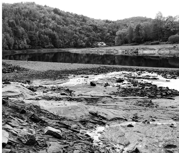
Kvůli geodetickému zaměření dna pod přehradou Orlík a zkoušek k ověření provozu zdejší vodní elektrárny ve zvláštním režimu došlo na kamýčkové přehradě od 4. do 7. října ke snížení její hladiny zhruba o čtyři metry pod minimální úroveň (282,10 m n/m).
