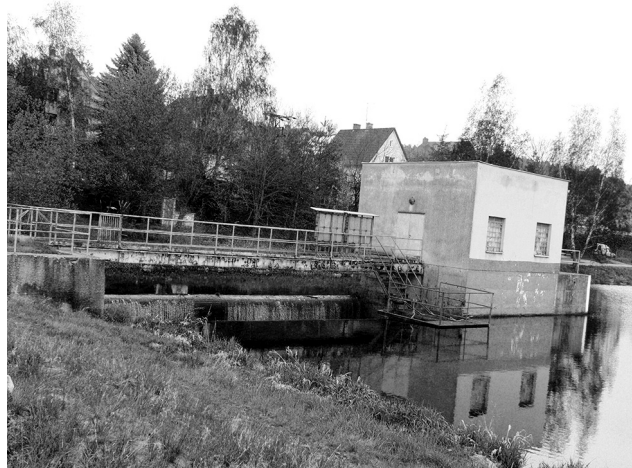
Rekonstrukci přehrady odhaduje současný starosta Hölzel na 100 milionů korun.
