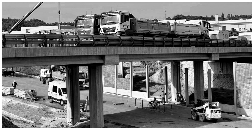
Zatěžovací zkoušky prověřily kompletně stav celé mostní konstrukce a slouží jako důležitý podklad pro kolaudaci obchvatu u Olbramovic. Foto: ŘSD
