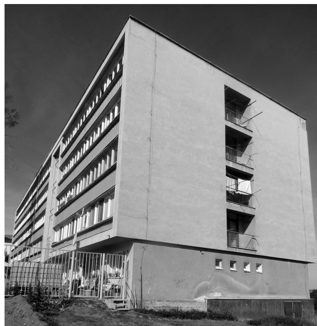
Jako modelový příklad využití fotovoltaiky by podle starosty nejlépe posloužila střecha městské budovy ve Strojírenské ulici.
