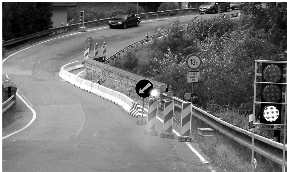
Osečanský kamenný most i horolezce, opravující jeho vnější strany v těchto dnech "hlídají" přenosné semaforey.
