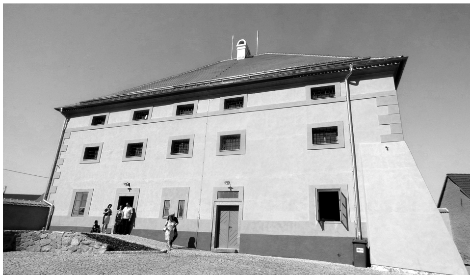
Povltavské městečko se může pochlubit rekonstruovanou bývalou tvrzí.
