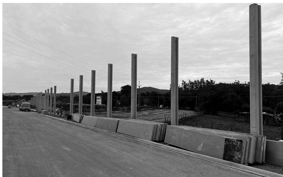
Výstavba obchvatu u Olbramovic, který má ulevit dopravě přes obec, zdárně pokračuje. Pro řidiče to však znamená v některých úsecích odklon na objízdnu trasu. Foto: ŘSD
