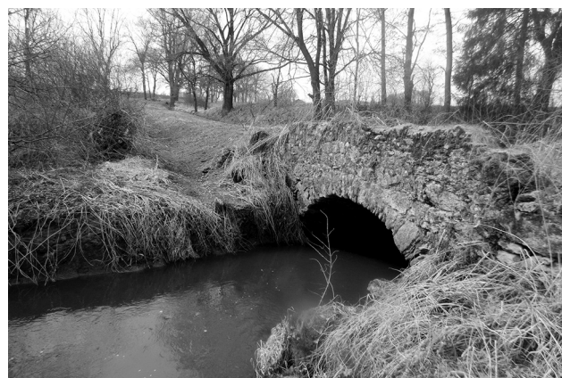
Nejvíce prací při obnově tří polních cest bylo odvedeno na úseku směrem od cyklostezky přes kamenný mostek pod Rudolcem do Klimětic. Zprovoznění vyšlo na čtvrt milionu korun.
