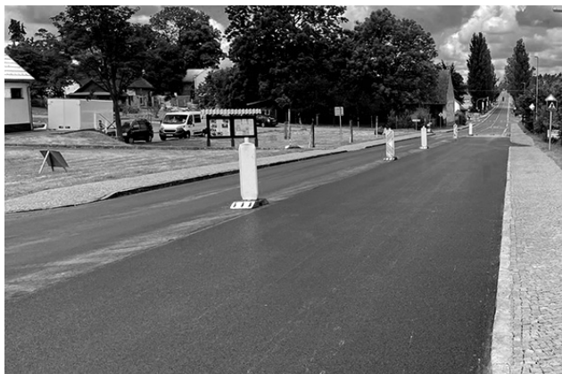
V Dublovicích silničáři pokládali minulý týden na komunikaci živice vrstvy. Foto: ŘSD
