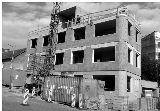
Při kopání základů tohoto domu byl nalezen několik staletí starý dubový trám.
