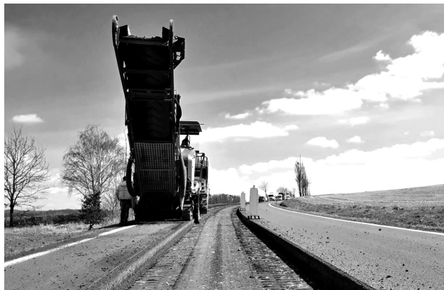
Práce na silnici I/18 je v plném proudu. Foto: ŘSD
