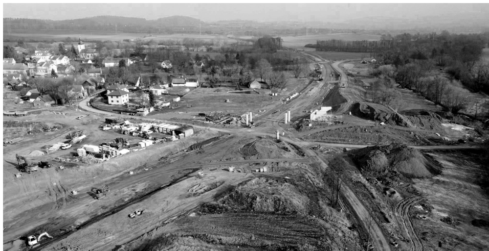
Práce na obchvatu pokračují oproti původnímu harmonogramu rychleji. Foto: ŘSD
