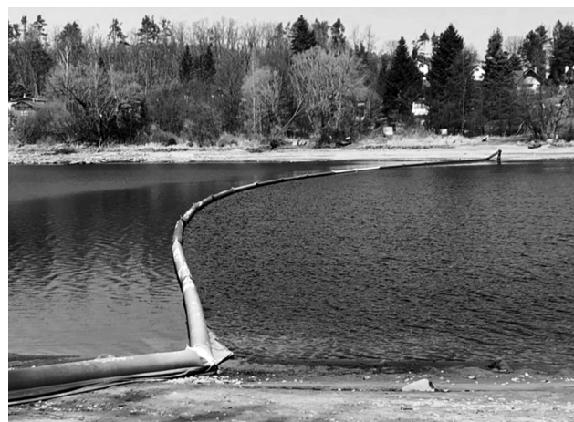
Na Zrůbku bylo položeno celkem 190 metrů normých stěn. Foto: Hana Procházková
